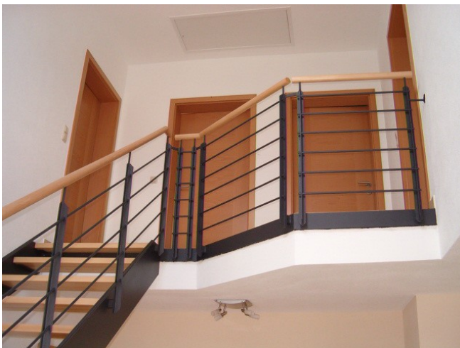
3. Deckenkante mit Estrichwinkel
